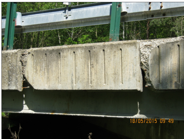
degradace betonu římsových prefabrikátů vpravo
