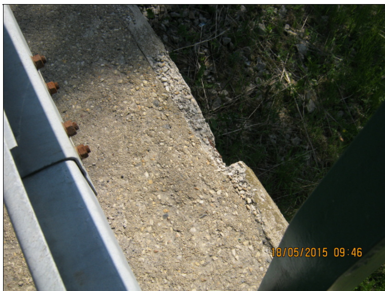
degradace betonu římsového prefabrikátu
