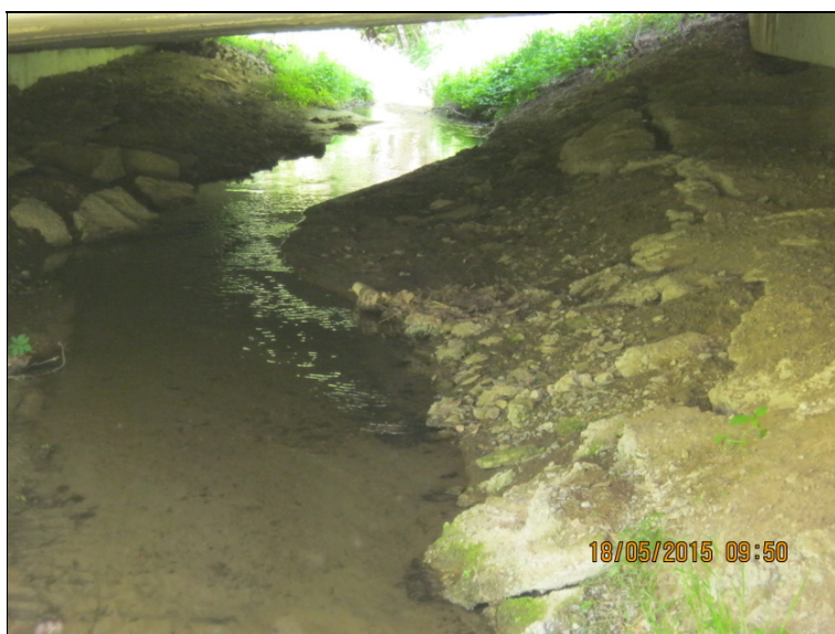
odtržené betonové zpevnění svahů pod mostem
