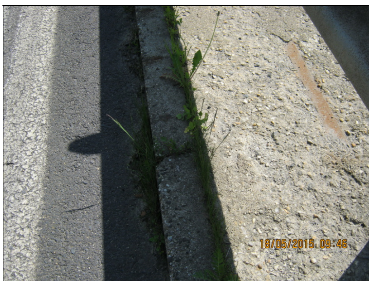
uchycená vegetace v římse mostu
