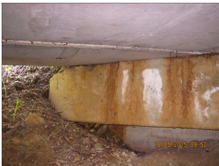
zatékání na ÚP OP2 vlevo
