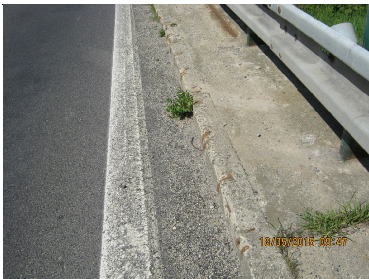
vyrezlá výztuž z betonových obrubníků
