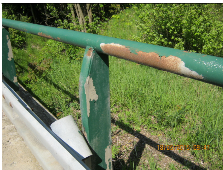
koroze zábradlí vlevo
