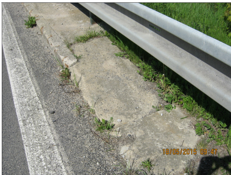
rozpraskaný přechodový beton římsy, uchycená vegetace
