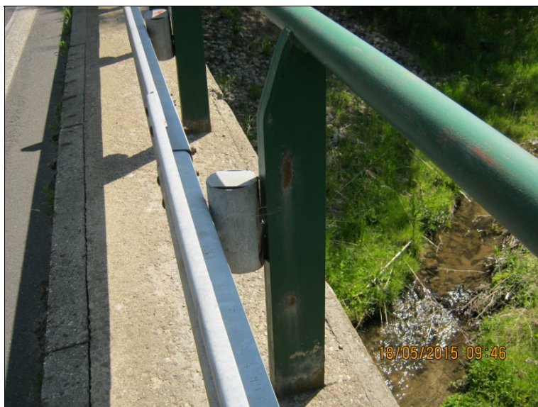
orezlý sloupek svodidla
